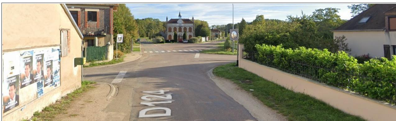
En section courante, la rue de l'Armanche a une largeur moyenne de 4,50 mètres. Elle est bordée d'accotements enherbés et/ou en grave calcaire et ne possède ni bordure, ni cheminement.
