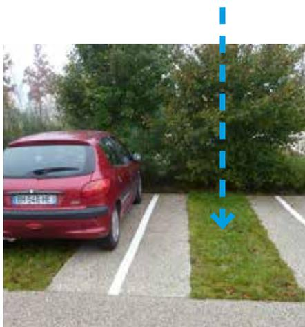
2 - Parking du Zénith à Strasbourg alternance de bandes enherbées perméables et de béton désactivé accueillant les véhicules
